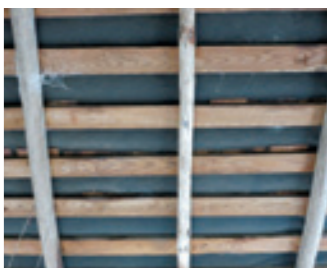
2 防水シートが貼られた屋根
